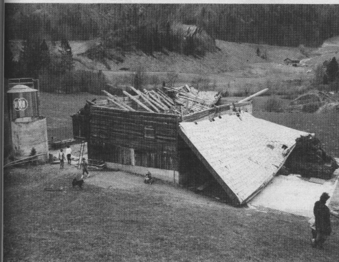
In diesem Stall in Unterschlat rissen die Sturmböen den ganzen Dachstock weg. Im Hintergrund verläuft die Enggenhüstrasse, die an verschiedenen Stellen durch umstürzende Bäume unterbrochen war. (Fotos: j.f.)
